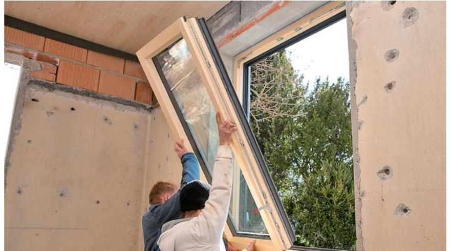
Der Fenstertausch wird idealerweise gemeinsam mit der Fassadendämmung durchgeführt – dadurch können die Anschlüsse optimal und wärmebrückenfrei ausgeführt werden.
