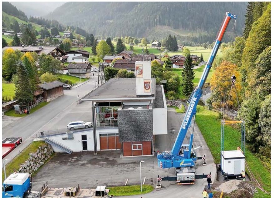
Mit einem Teleskopkran konnte die Ortszentrale 02 Aschau beim Feuerwehrhaus platziert werden.
