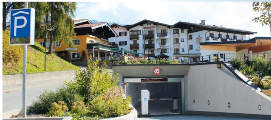
Die Parkgarage in Kirchberg wurde einer Komplettrenovierung unterzogen und bietet nun höchsten Komfort.
